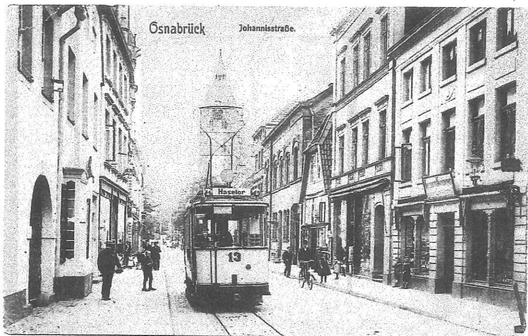
Diese Postkarten aus den ersten Tagen des Betriebes zeigen sehr gut den Kassierer-Spiegel über dem Fahrer sowie rechts neben dem Fahrer den Zahlkasten in der Trennwand zum Fahrgastraum.
